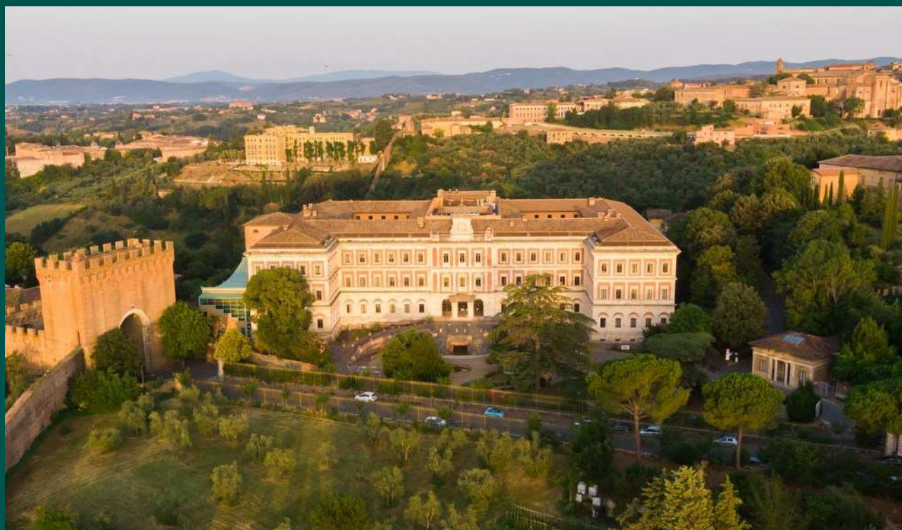
Complesso universitario San Niccolò
