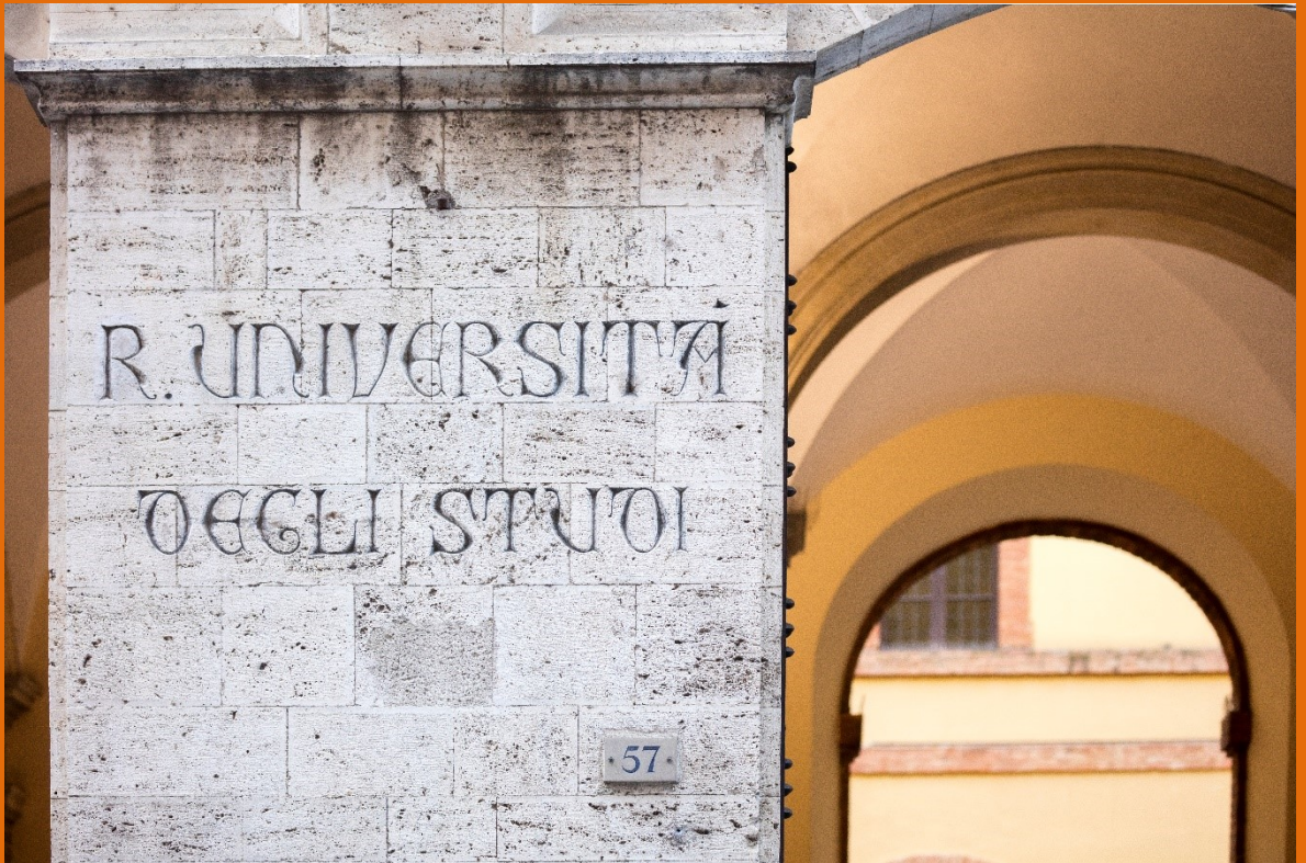
Particolare della facciata del palazzo del Rettorato
