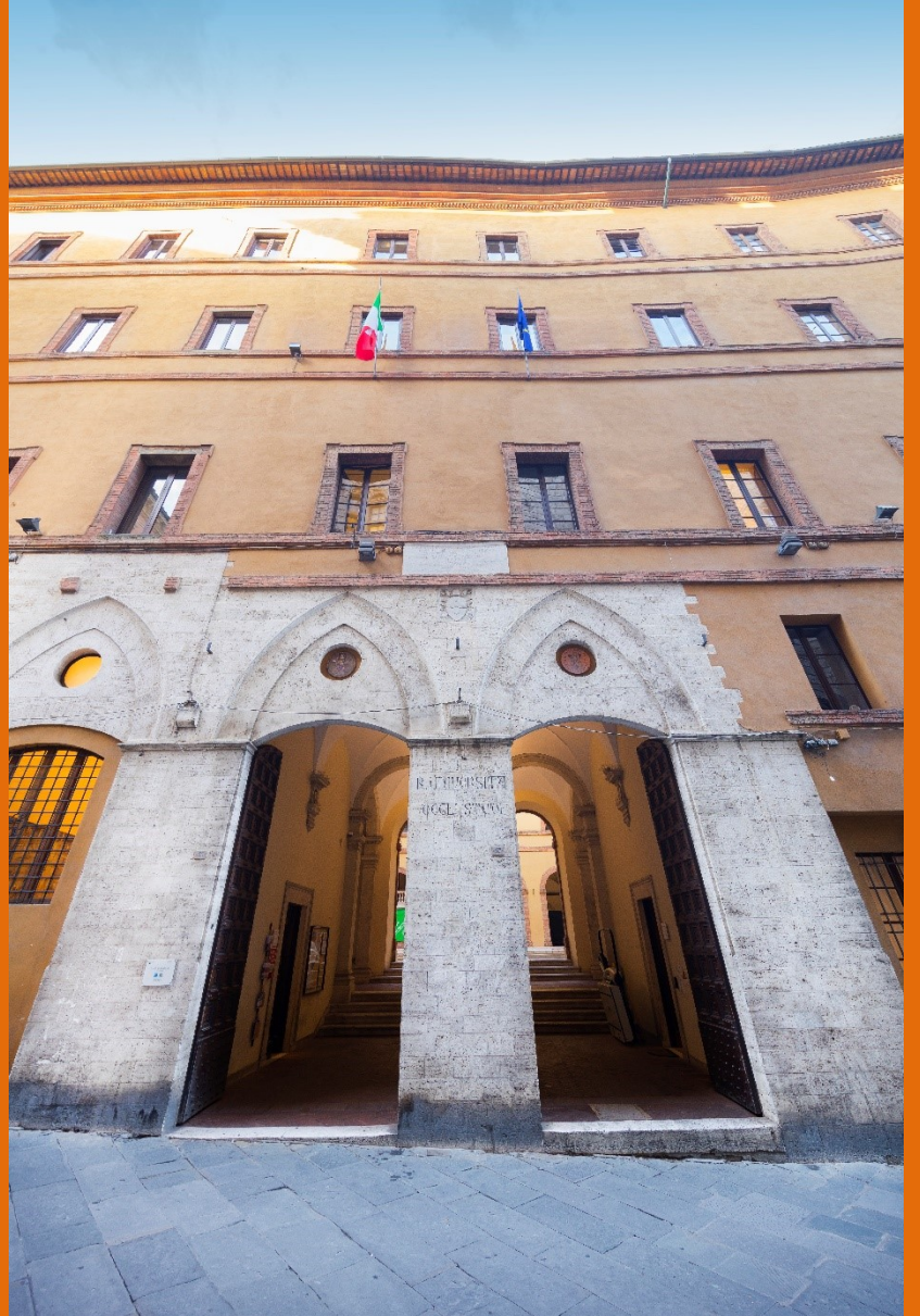
Facciata del palazzo del Rettorato
